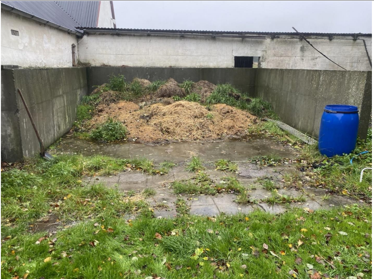
Møddingsplads manglende overdækning
