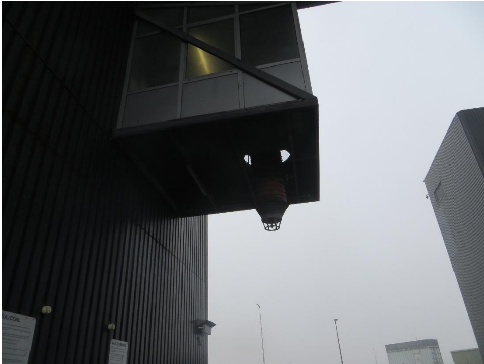
Udmadning af aske som er anlæggets eneste restprodukt fra røggasrensningen
