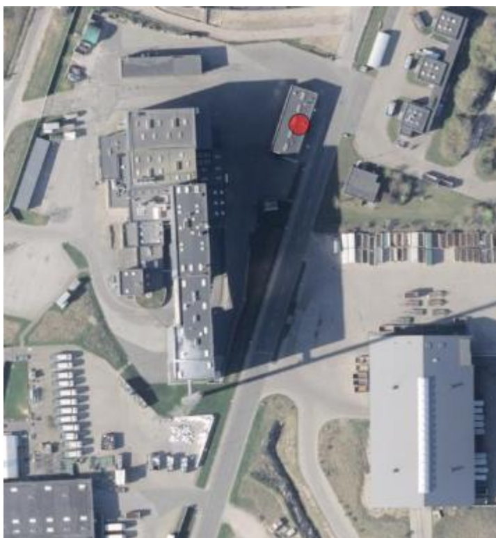
Ortofoto 2025 Nordværk Affaldsenergi A/S Hjørring med modtagehal for genanvendelige materialer (nederst til højre)
