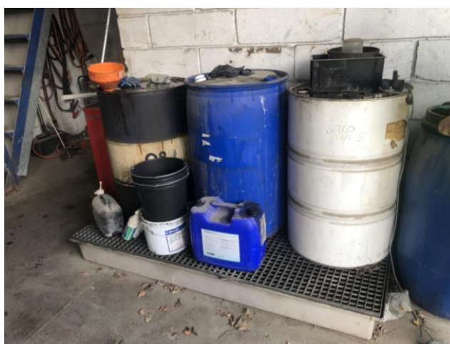
Billede 3. Opbevaring af spildolie med rist og opsamling
