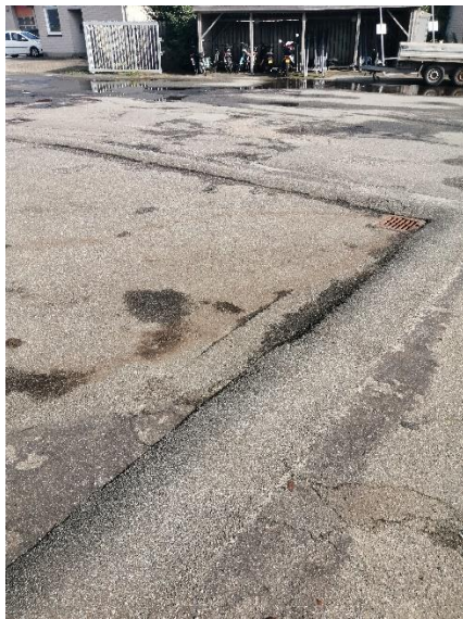
Billede 1. Vaskepladsen øst for garagen med opkant og to afløb tilkøbet olieudskillere.
