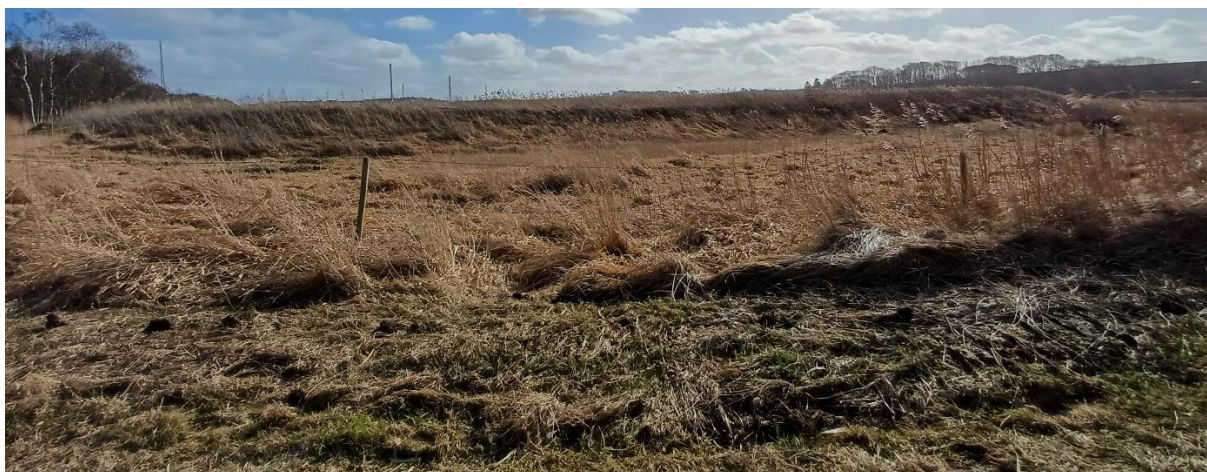
Figur 6: Stånum – nordvestlige hjørne. Det forreste viser den resterende lave digekrone, hvor det originale dige stod, og bagerst ses det nye dige.
