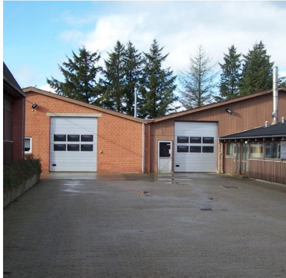
Afkast fra affedtningsanlæg i midten og komfortventilation i kontorafsnit til højre
