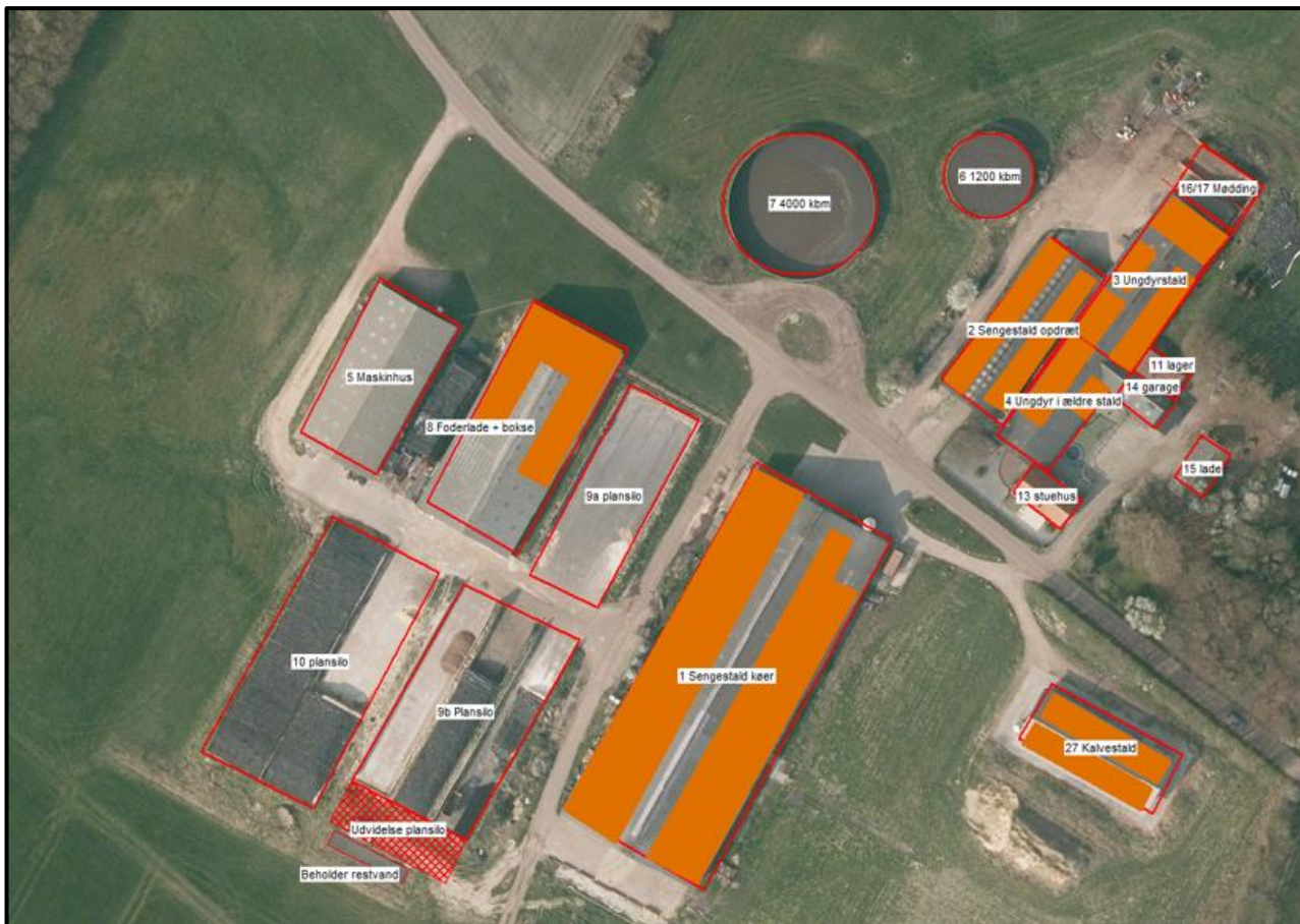
Figur 4. Oversigt over staldafsnit med angivelse af placering af produktionsarealer, opbevaringsanlæg og øvrige driftsbygninger. De orange felter er de områder af staldene hvor produktionsarealerne er placerede. Figur udarbejdet af ansøger.
