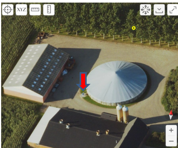
Fig. 1: Eksisterende fortank forhøjes, se under rød pil.
