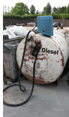
Billede 1. Dieseltank ved Materielgård.
