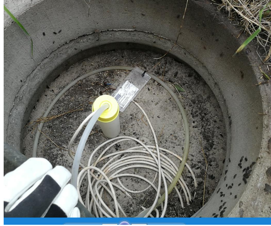
Boring med DGU nr. 1.664; SK1
