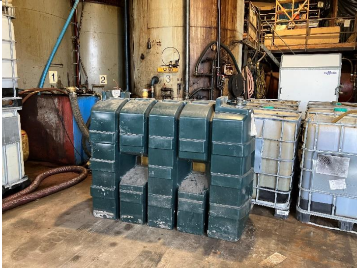
Hal 1 med oplag af spildolie. Hævet sokkel, afløb til sump.
