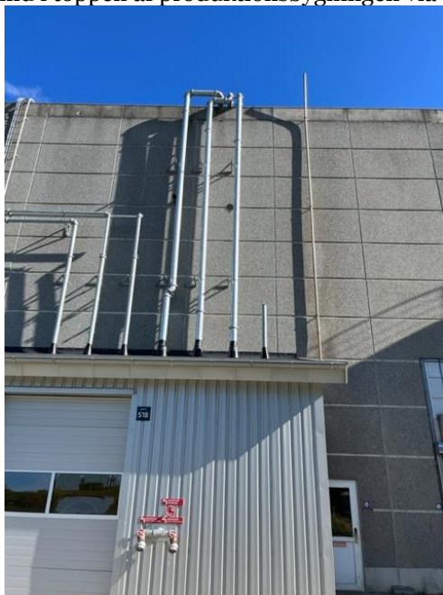
Foto 3: Bygning med brandslukningsanlæg
