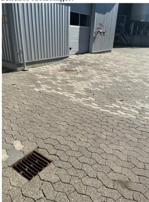
Foto 4: Afløb og befæstet område udenfor bygningen
