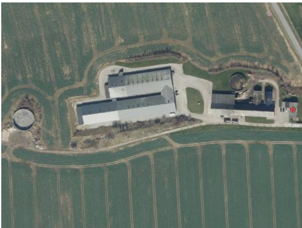
Figur 1. Oversigt over bygninger.
