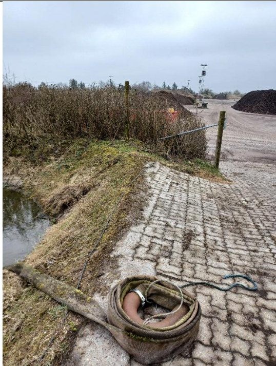
Ovenfor: Slange til overpumpning til container i lagune 2
