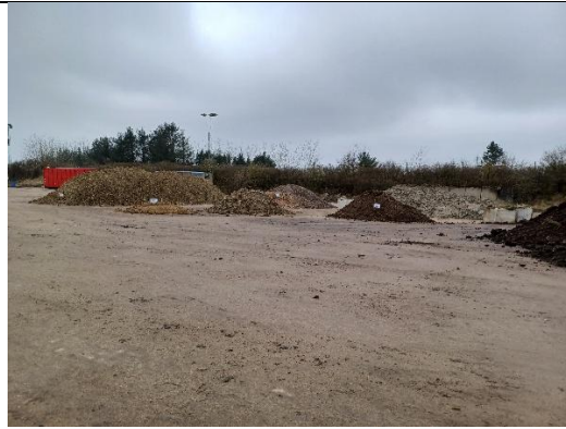
Herover eksempler på jordbunker til kartering og rensning, markeret med skilte.
