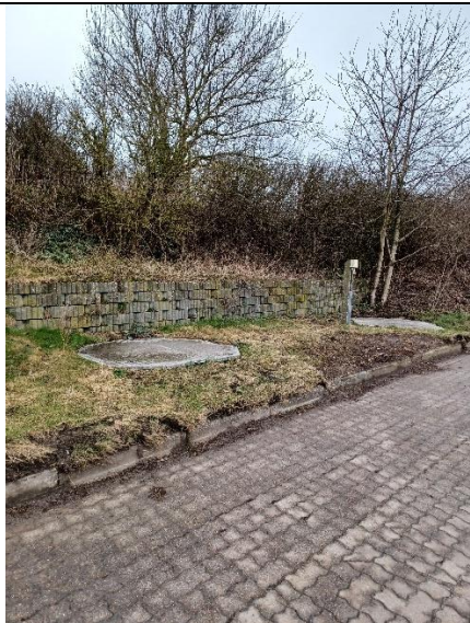
Pumpestation 1 beliggende midt for lagune 1
