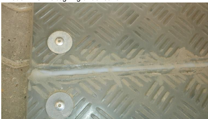
Billede nr. 8: Svejsning mellem 2 plastunderlag.
