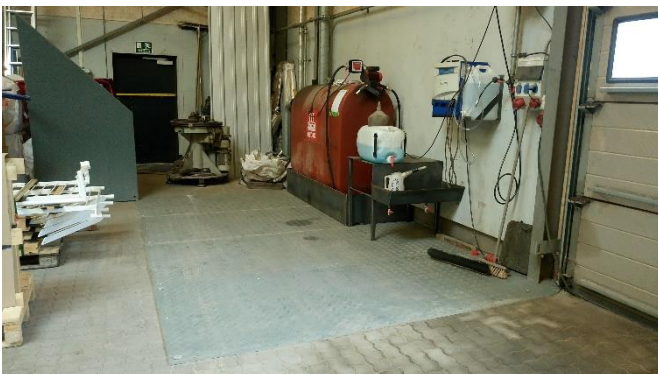
Billede nr. 4: Belægning og opsamlingsbakke ved dieseltank, tankningsplads og bord med flydende produkter
