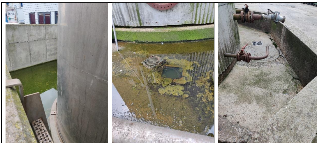
Figur 1 Eksempler på ikke tømte og rengjorte tankgårde (venstre foto: tank med formalin, højre foto: lille tankgård til fiskeolie).
