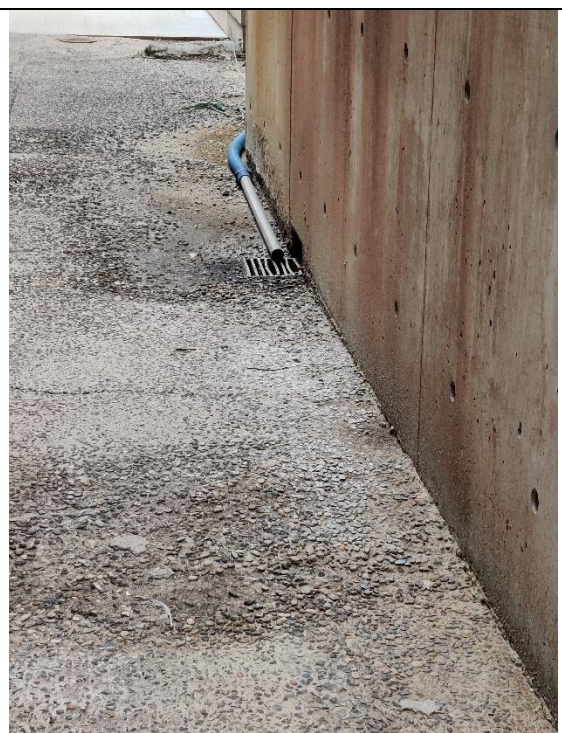
Figur 6 Overløb af kondensvand fra kemisk scrubber for luft før luften ledes til kedlerne.
