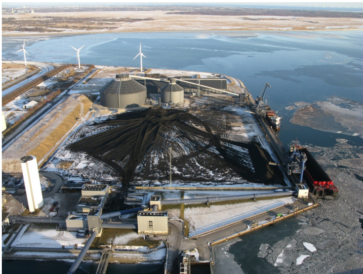
Figur 8: Foto fra 2012 af Avedøreværkets østlige område med kulplads og træpillelager, herunder den store lagersilo til træpiller som ikke indgår på figur 7.
