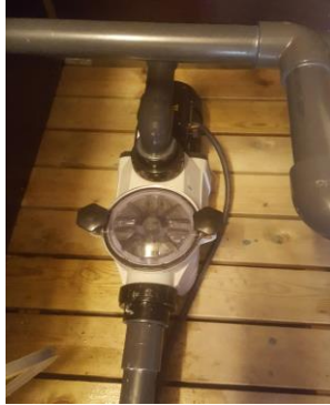
Tryksandfiltret (Ø900mm) Ny cirkulationspumpe.
