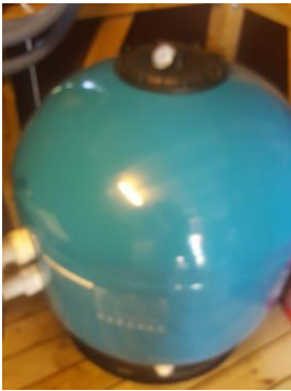
Tryksandfiltret (Ø900mm) Ny cirkulationspumpe.
