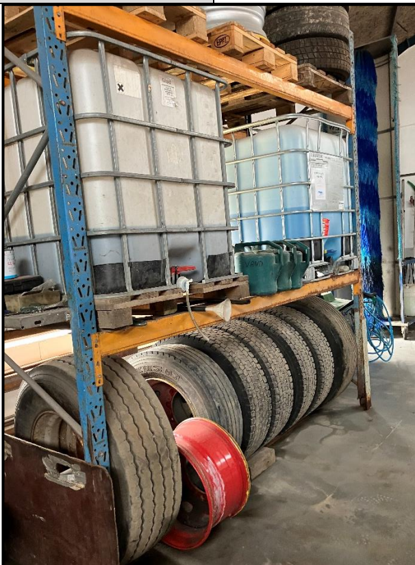
Sprinklervæske i garage ved afløb
