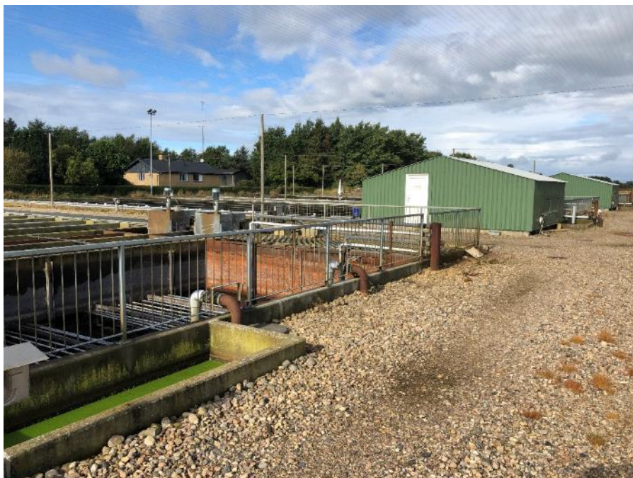
Huse for iltningsanlæg og pumper
