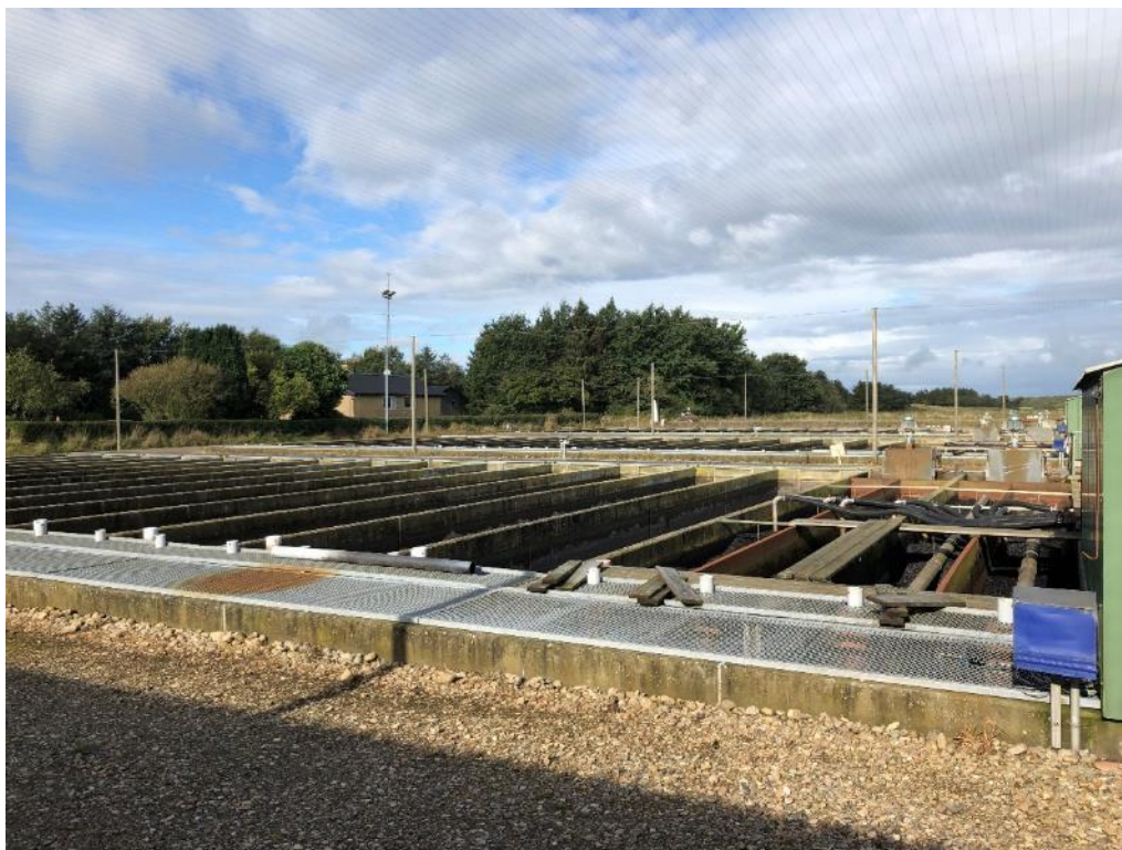
Indretning af kummeanlæg, hævnning over eksisterende terræn
