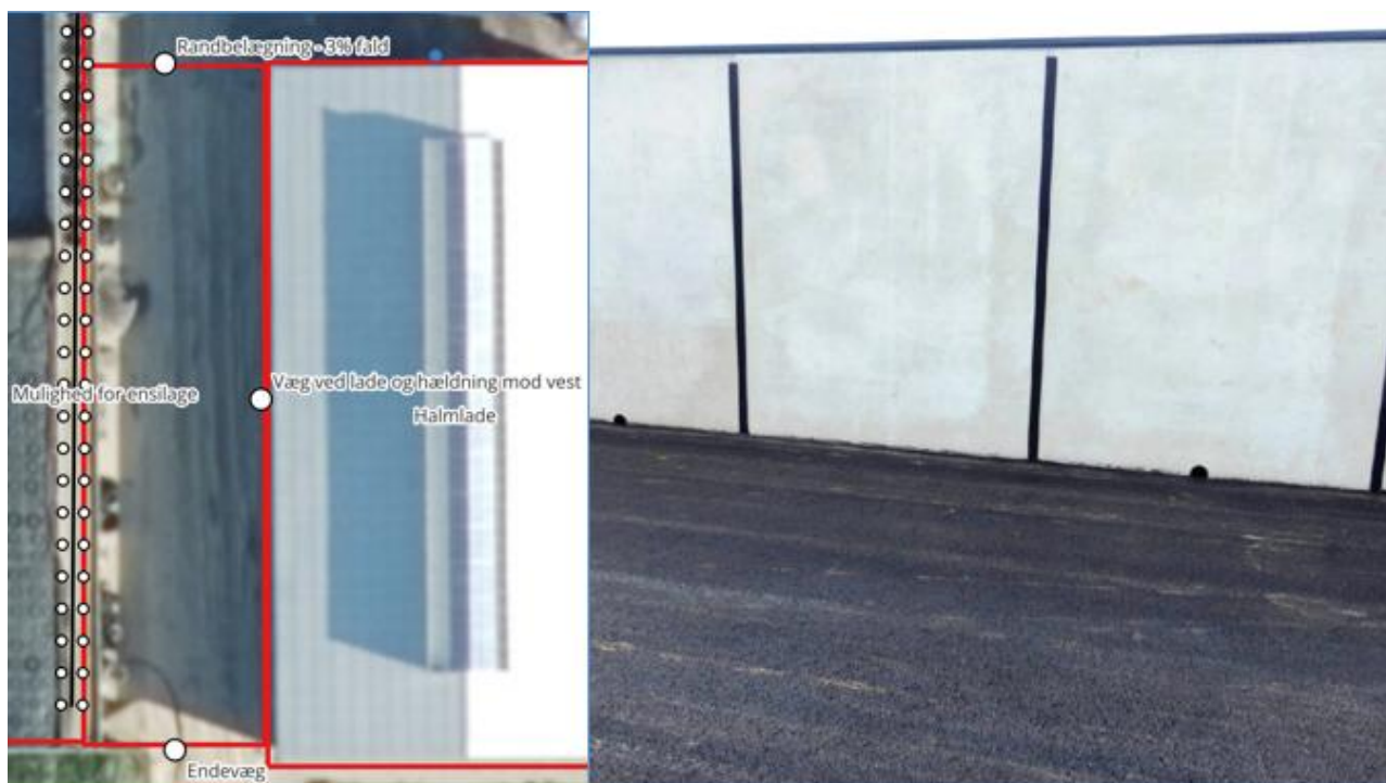
Figur 14 Viser indretning af plansiloen (bygning 8), mens billedet til højre viser hvordan afløbene er etableret i plansilovæggen (figur fra ansøger).
