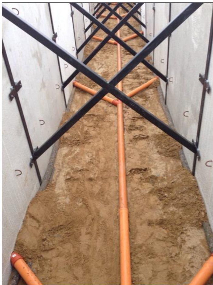
Figur 20 Billede af den indlagt drænslange i indersiden af plansilovæggene, hvor der er afløb ned langs plansiloens sider. Se Figur 14 for billede af afløbene inde i plansiloen.
