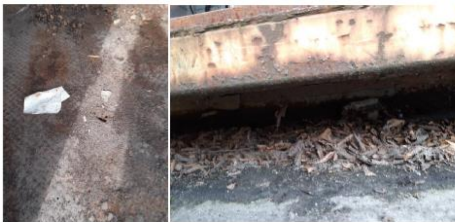
Figur 6 Container til farligt affald med dobbeltbund, hvor den øverste bund er rusten og har gennemtæring (billedet tv). Den nederste bund bar også præg af rust og mulig gennemtæring, der er bunden, der kan skimtes, en 3 cm tyk rille, ses der, hvor der hænger et blad ned fra (th).
