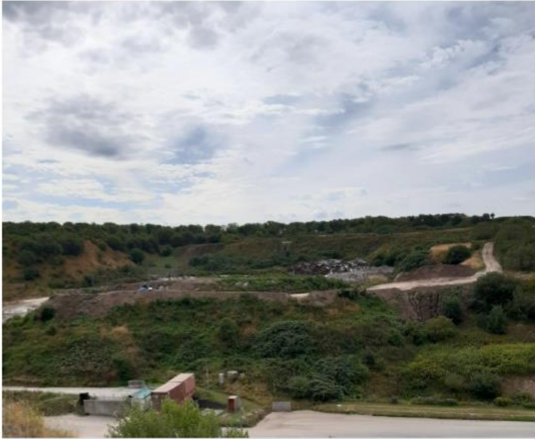
Figur 3 hævede skrænt ved enhed 4.2.1 til asbest.
