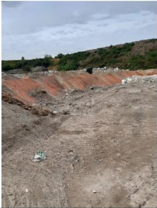
Figur 4 hævede skrænt til etapen til PCB-affald.
