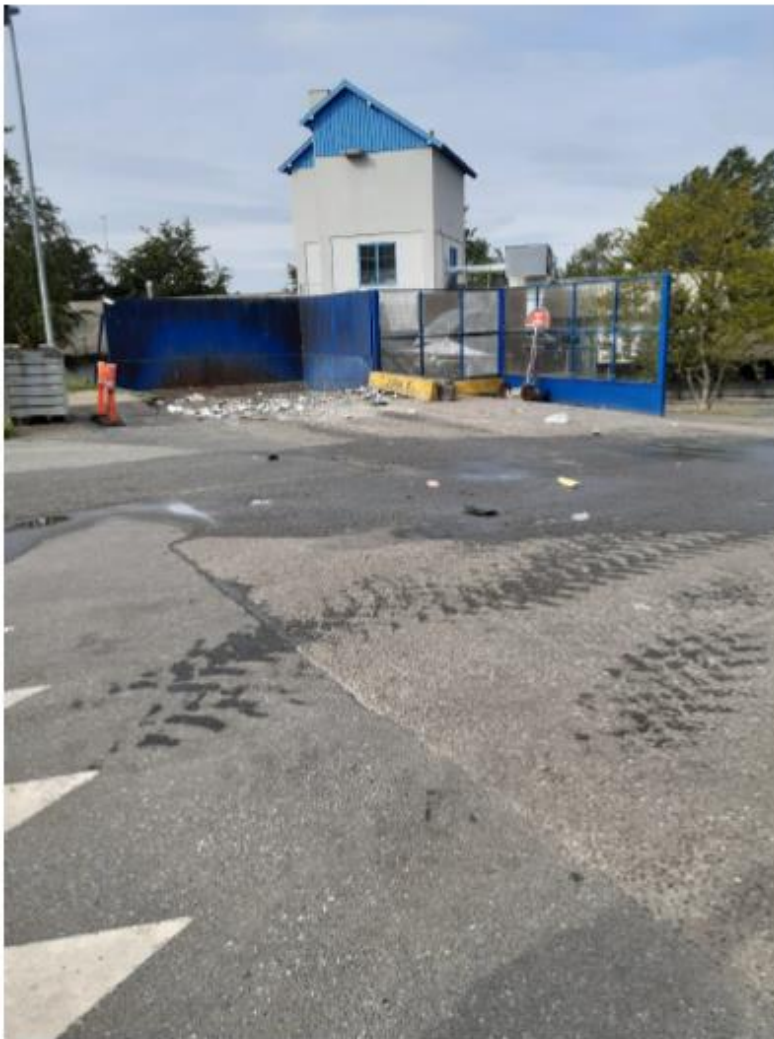
Figur 11 Tragten til sorteringsanlægget for flasker, metal og plast.
