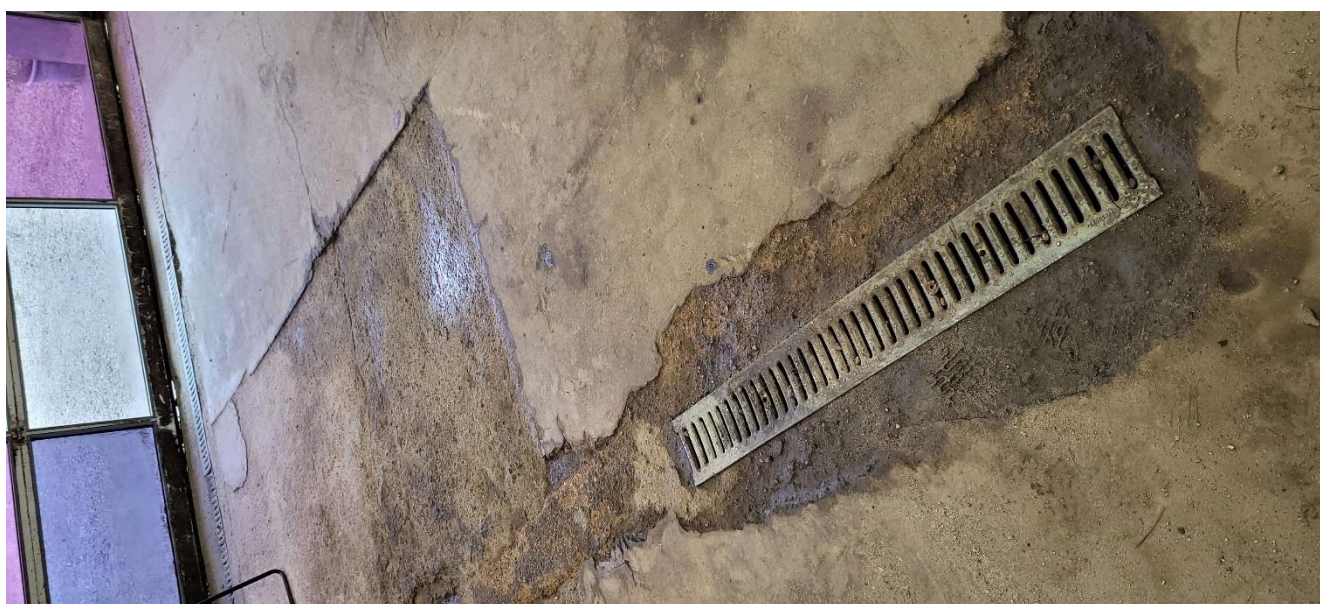
Der er gulv afløb i værkstedslokalet, hvor der ikke håndteres flydende olie og kemikalier.
