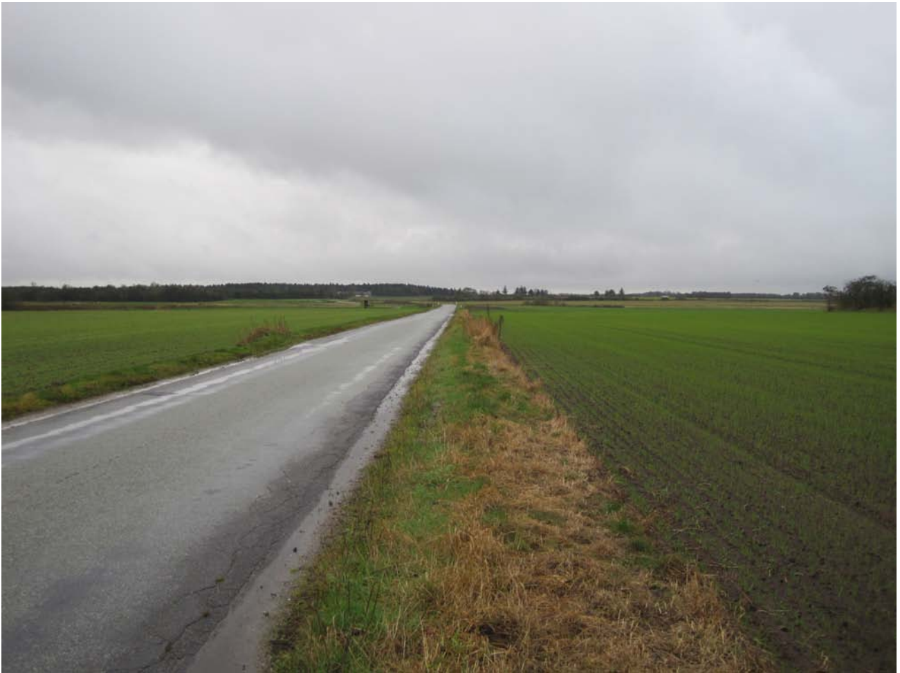
Figur 1: Foto mod syd. Skarvadvej med planlagt anlæg til højre for vejen
