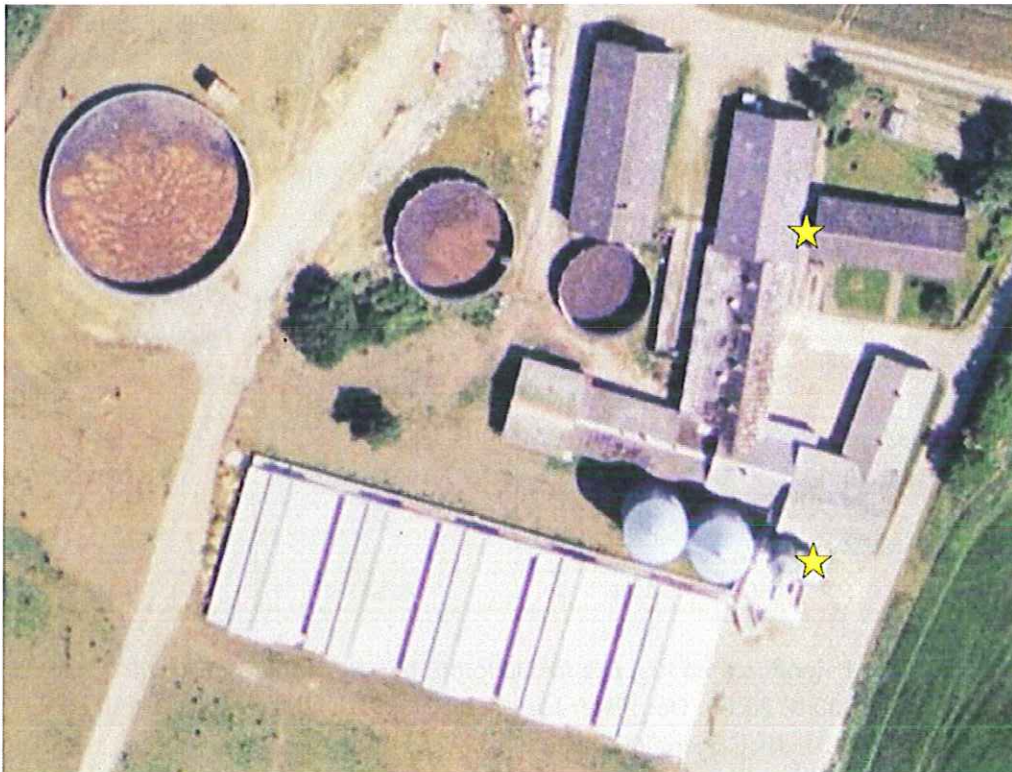
Figur 1. Placering af udendørs arbejdsmæssig belysning, markeret med ★
