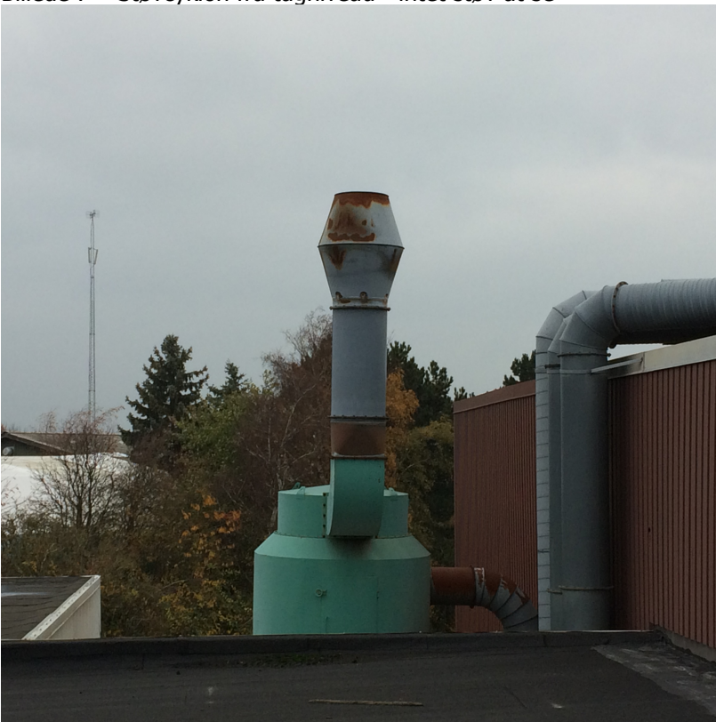
Billede 7 – Støvcyklon fra tagniveau - intet støv at se
