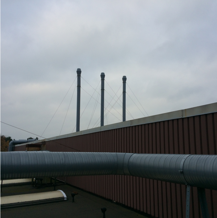
Billede 16 Tre luftafkast over tag
