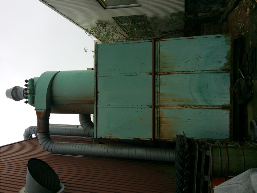
Billede 6 – Støvcyklon fra jordniveau
