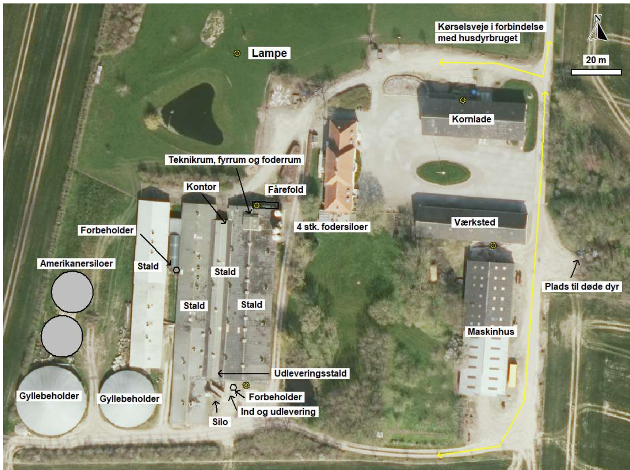
Figur 10: Støjklider (og udvendig belysning)
