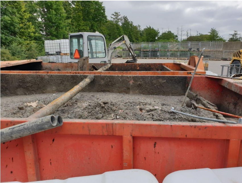
Åbne containere på oplagsplads
