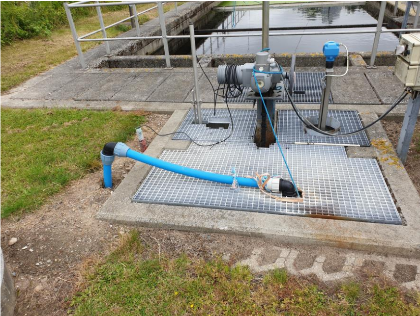
Udløb fra Flux Water til Slagelse Renseanlæg.
