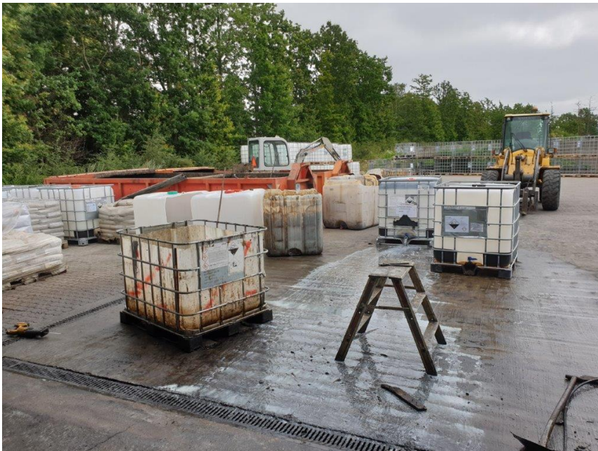
Tømning af farligt affald fra palletanke via riste til gulvtank
