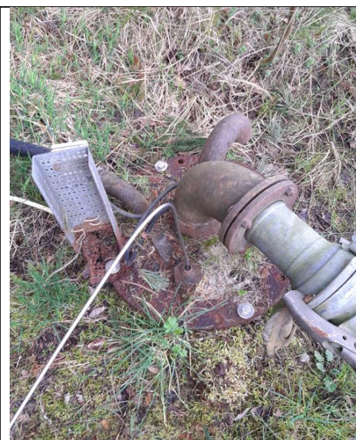
Billede 3. Den synlige del af perkolatbeholderen.
