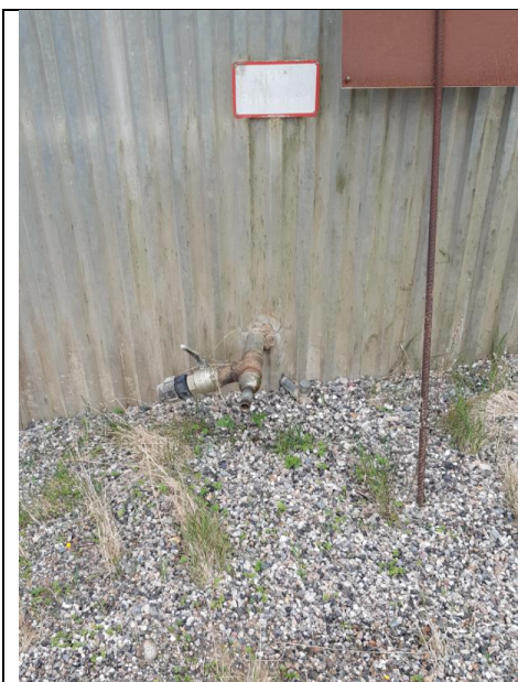
Billede 9. Formodet taphane til DGU-nr. 71.399.
