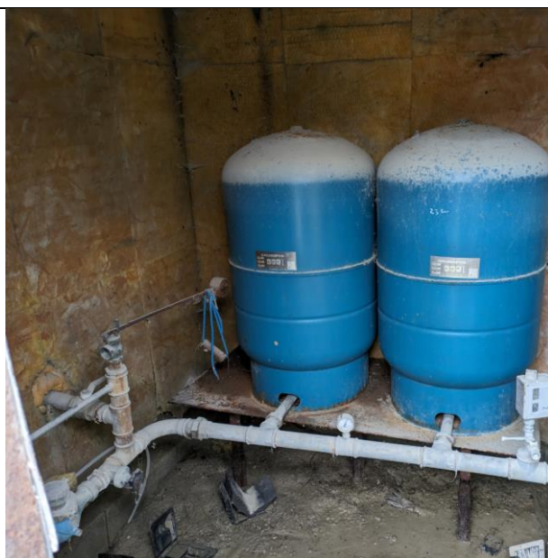
Billede 10. Vandtrykforøgere. Formodes tilknyttet boring DGU-nr. 71.399.
