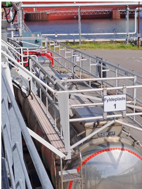
Billede D – Igangværende påfyldningsproces. Gitter føres ned til tankdæksler. Drypspand på påfyldningsstudsene ses svagt i billedets venstre hjørne.
