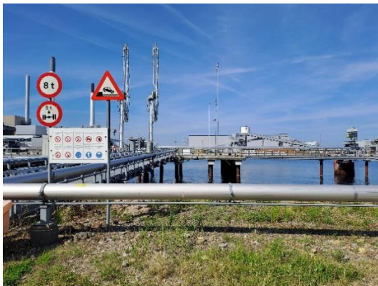
Billede C – Til venstre ses pieren hvor tankskibe kobles på rørføring og leverer Salpetersyre; Til højre ses tank, tankgrav og rørbro nordfra.
