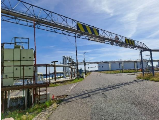
Billede B – Til venstre ses rørbro med ekstra fareskilt; Til højre ses et hjørne af rørføringen.
