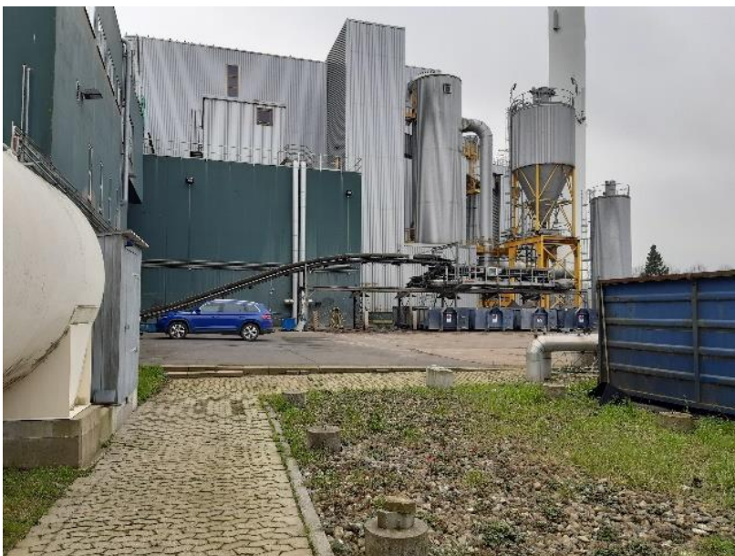
Photo 7 - Slaggebånd til udlosning i containere i baggrunden
