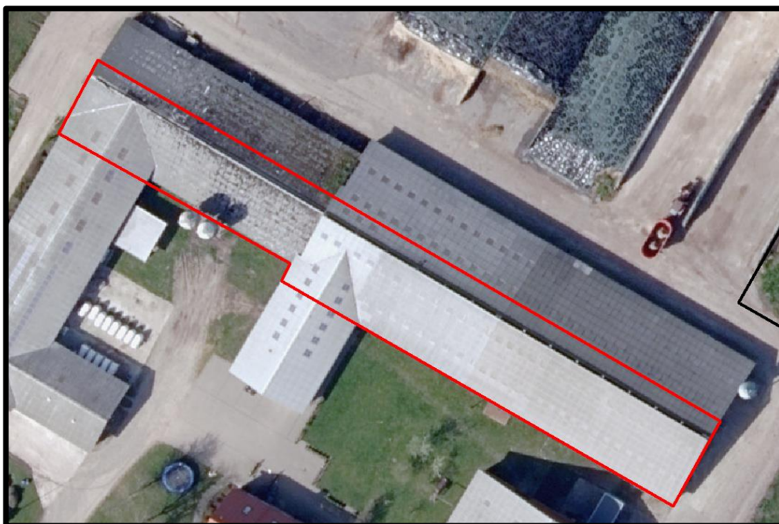
Figur 7. Område, hvor der skal være installeret skraber på spaltearealerne.
