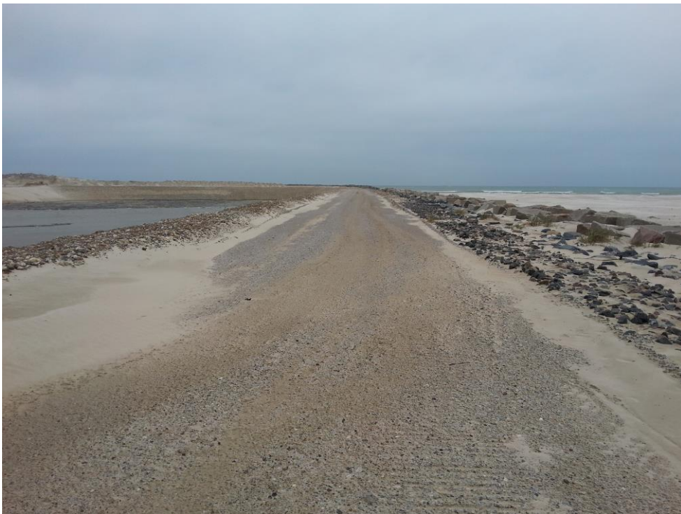
Hirtshals Havn. Nyt deponi etableret i april 2017. Ydre dæmning adskiller deponiet fra havet.
