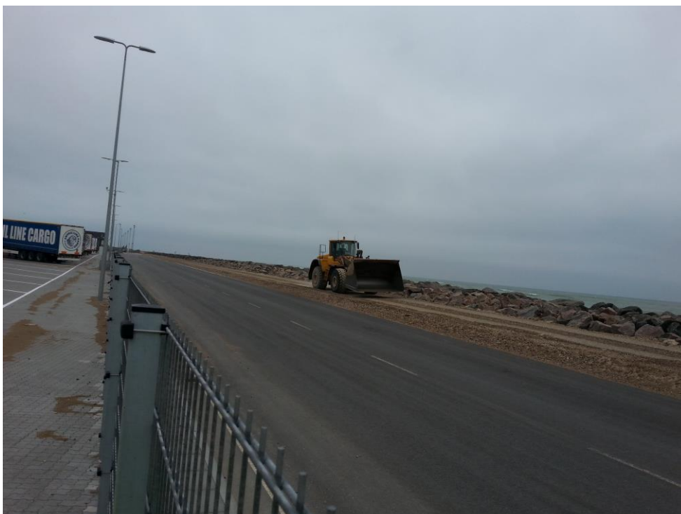
Hirtshals Havn. Gamle nedlukkede deponi. Ydre dæmning med kørevej.
