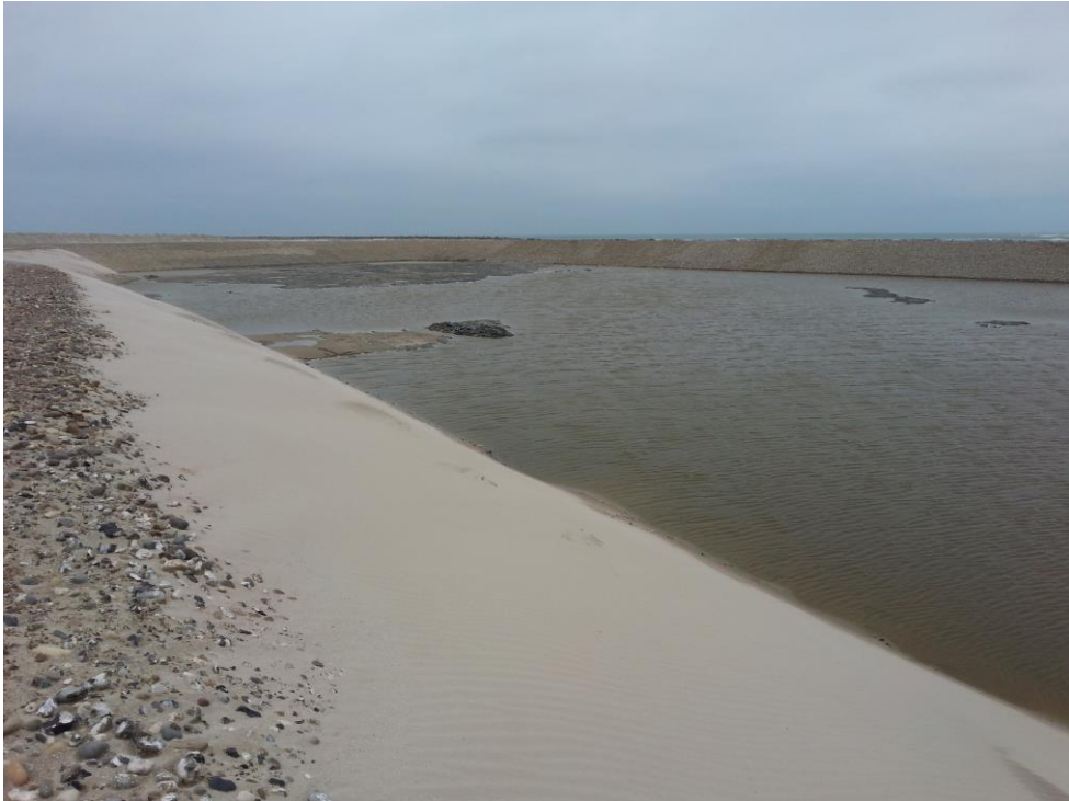
Hirtshals Havn. Nyt deponi etableret i april 2017. Sydvestlig dæmningskråning er dækket af fint sand pga. sandfygning.
