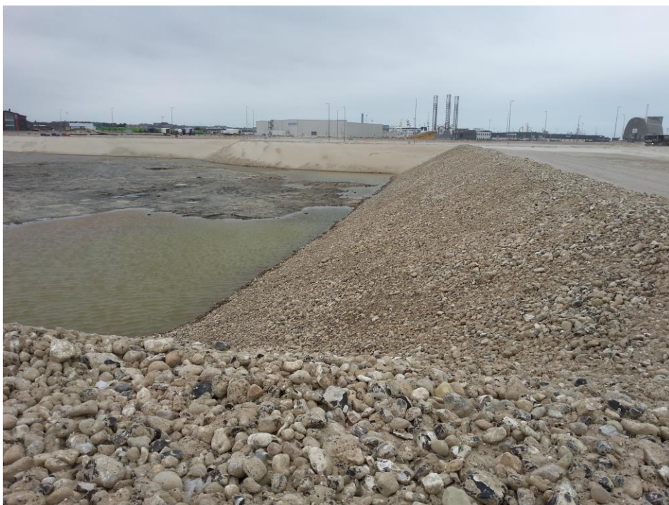
Hirtshals Havn. Nyt deponi etableret i april 2017. Indre dæmninger med beskyttende stenlag.
