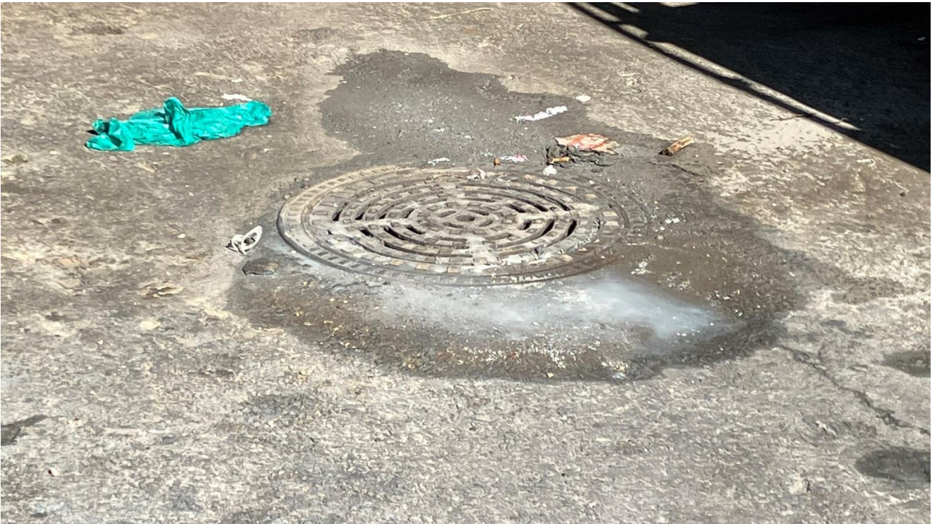
Afløb i vaskeplads
