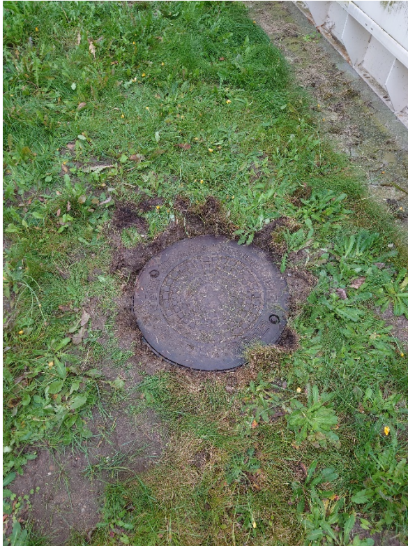
Nedgravet 10.000 liters dieselolietank fra centralens etablering. Aldrig brugt.
