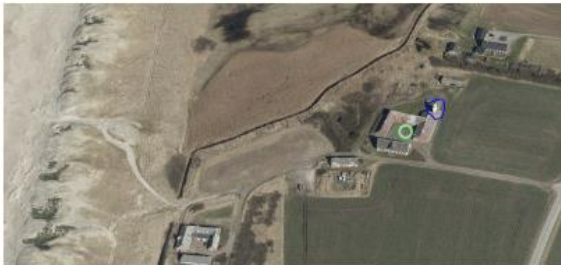
Figur 2. Skråfoto 2021. Ejendommen markeret med grøn cirkel, og siloer indtegnet med blå streger
