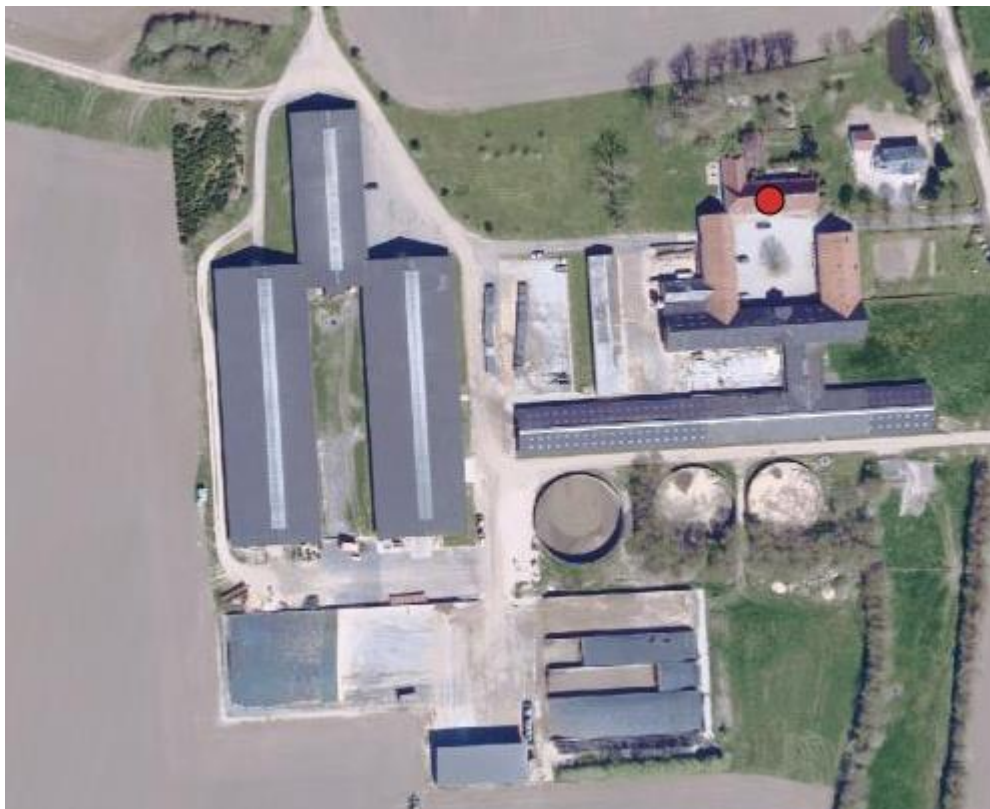
Figur 1. Oversigtskort over gyllebeholderne på ejendommen Fynslundvej 59
