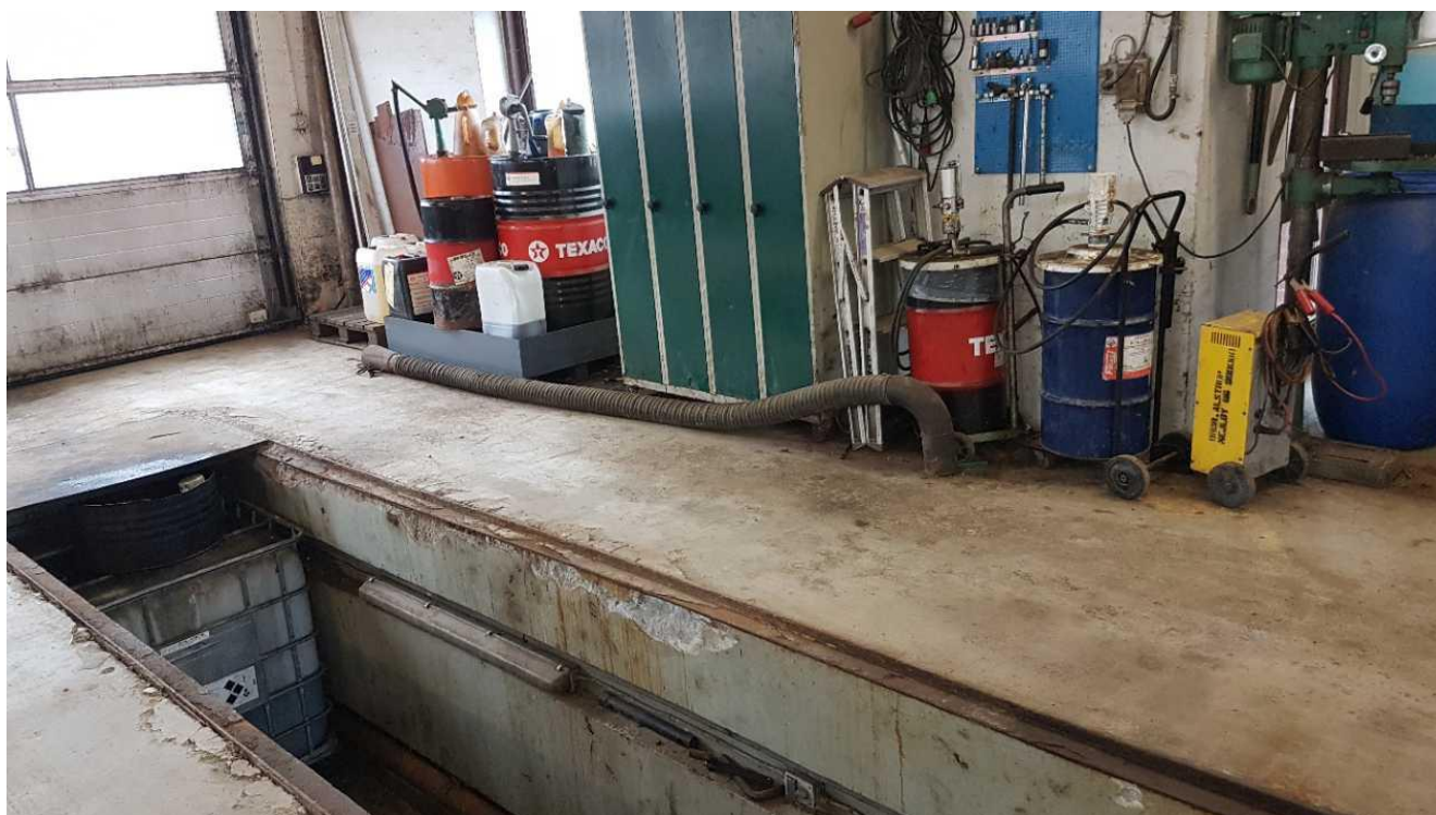
Punktudsugningsslange til udstødningsgas m.m.
