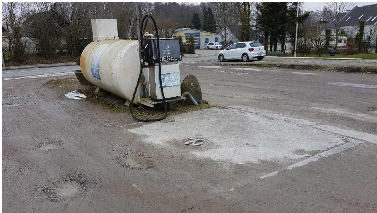
Betonbefæstet påfyldningsplads med afløb via olieudskiller.
