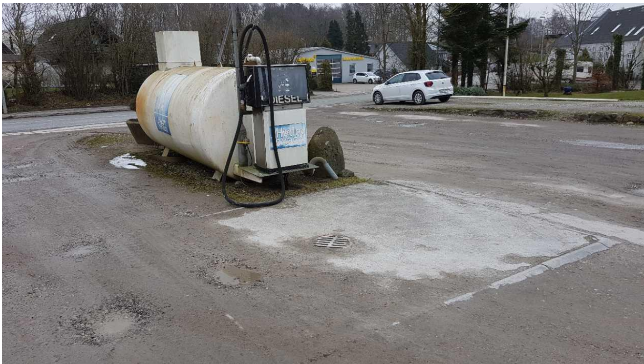
Afløb fra dieselpåfyldningsplads.
