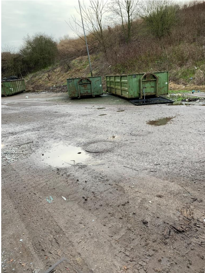
Foto 5. Placering af olieudskillere ved tankanlæg.
