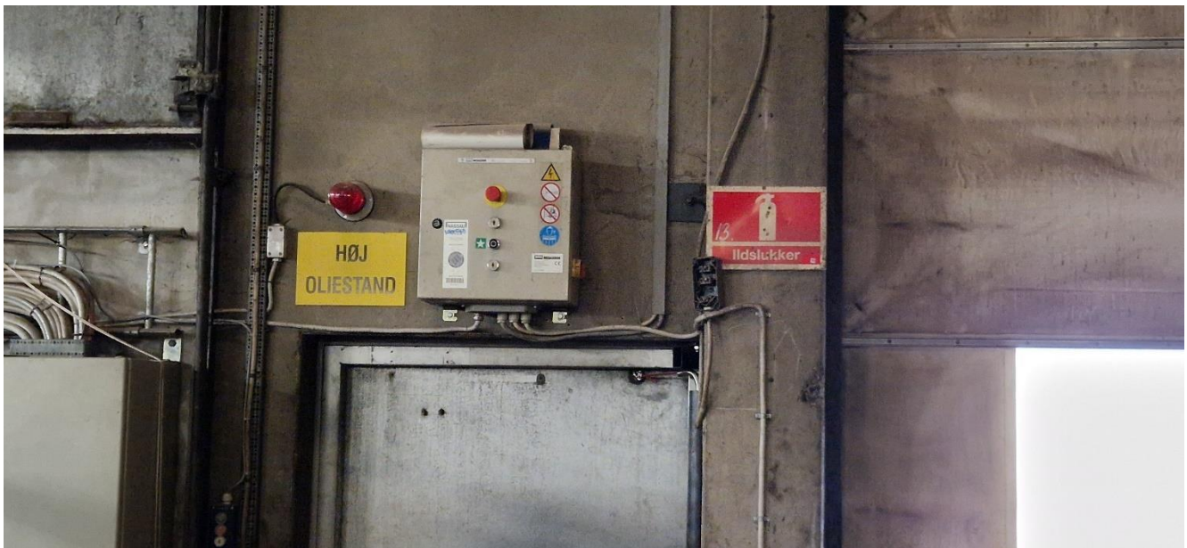
Olieudskilleren er udstyret med alarm, som aktiveres når maksimal oliestand nås.
