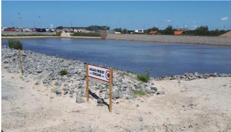
Foto 4: Dobbelttrådet hegn og fareskilte rundt om deponiet. I baggrunden det nordvestlige hjørne af deponiet.
