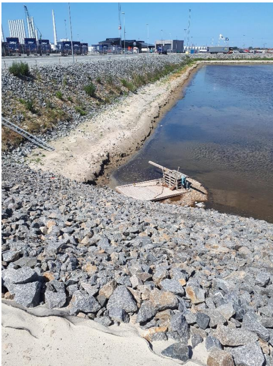
Foto 1: Deponiets sydøstlige hjørne med skrænt mod havneområdet til venstre. Bemærk fiberdug nederst i billedet under håndstenene.
