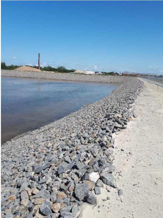
Foto 2: Deponiets østlige dige og i baggrunden det nordlige dige.
