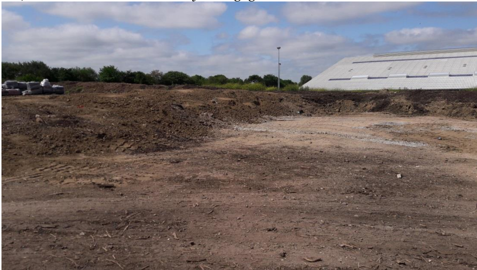
Figur 3 areal til affald fra brandtomter indeholdende asbest. Her afdækkes straks med jord.
