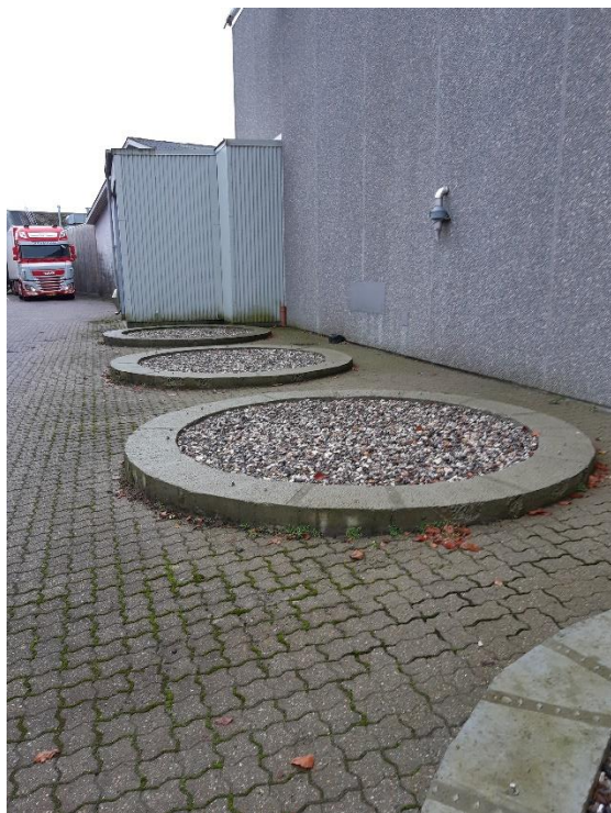
Fundamenter fra færdigvaresiloer.
