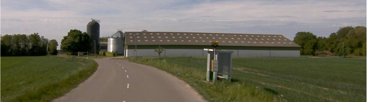
Foto 3.2.1 Staldbygninger og siloer set fra nord på Brandstrupvej
