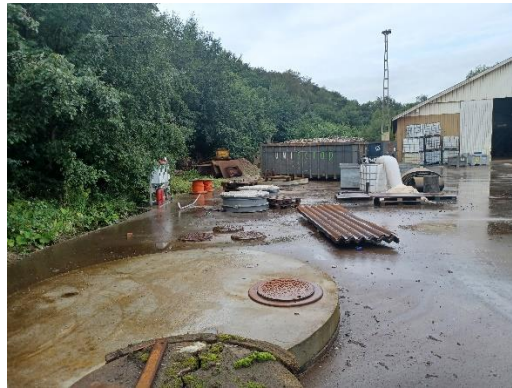
Ny belægning ved sandfang og olieudskillere
