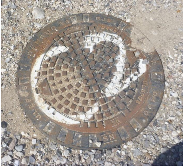
Figur 5: Perkolat brønne af type som C2 på bådspladsen, dvs. den type man kan køre hen over, er blevet tætnet mod gasudsivning i forbindelse med biocoverprojektet.
