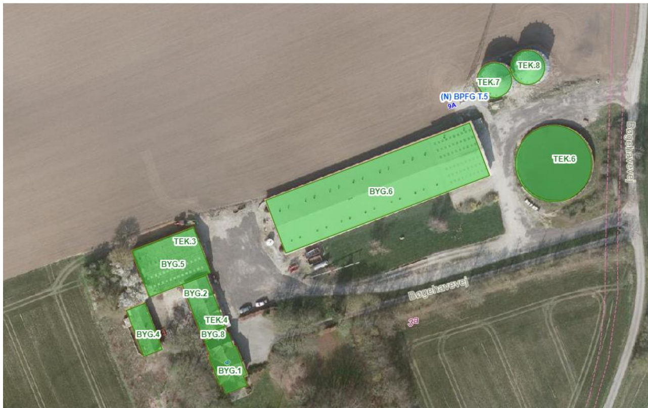
Luftfoto 2.4.1. oversigt over ejendommen TEK anlæg og bygninger ifølge BBR.
