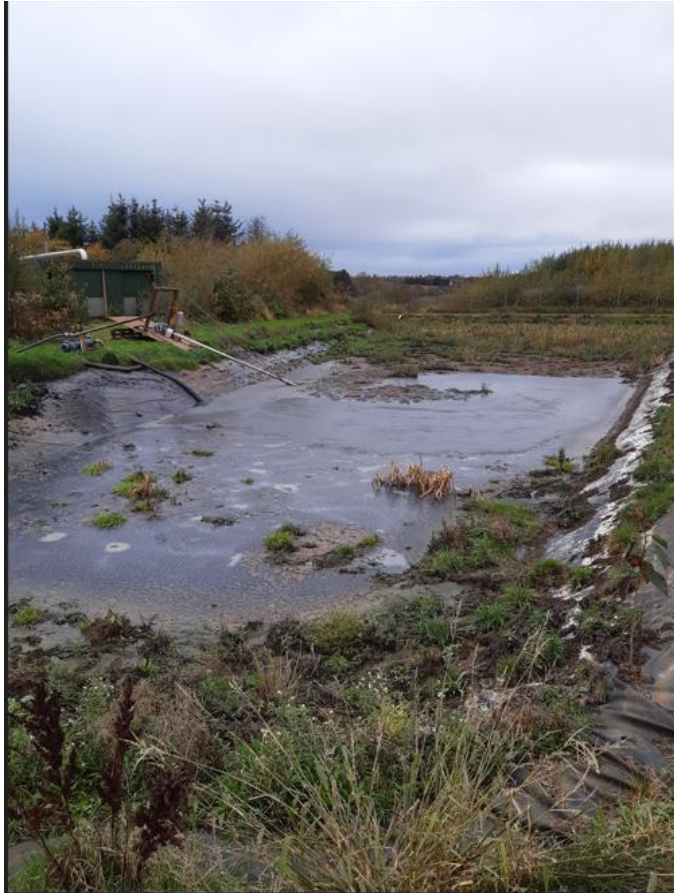
Fig. 10. Lagune der ikke længere er i brug.
