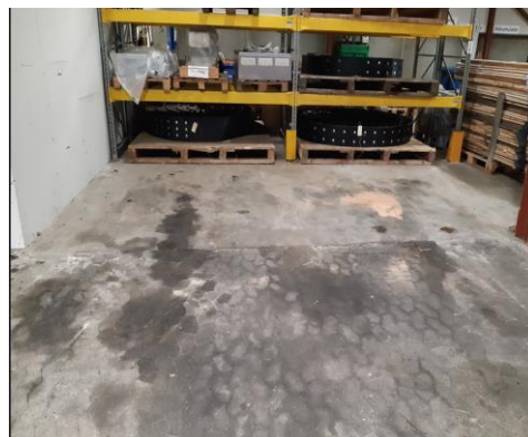
Fig. 2. Område, hvor trucks holder parkeret. Foran reolen er der tæt belægning, hvilket også gælder for et større område i den del af hal 40.
