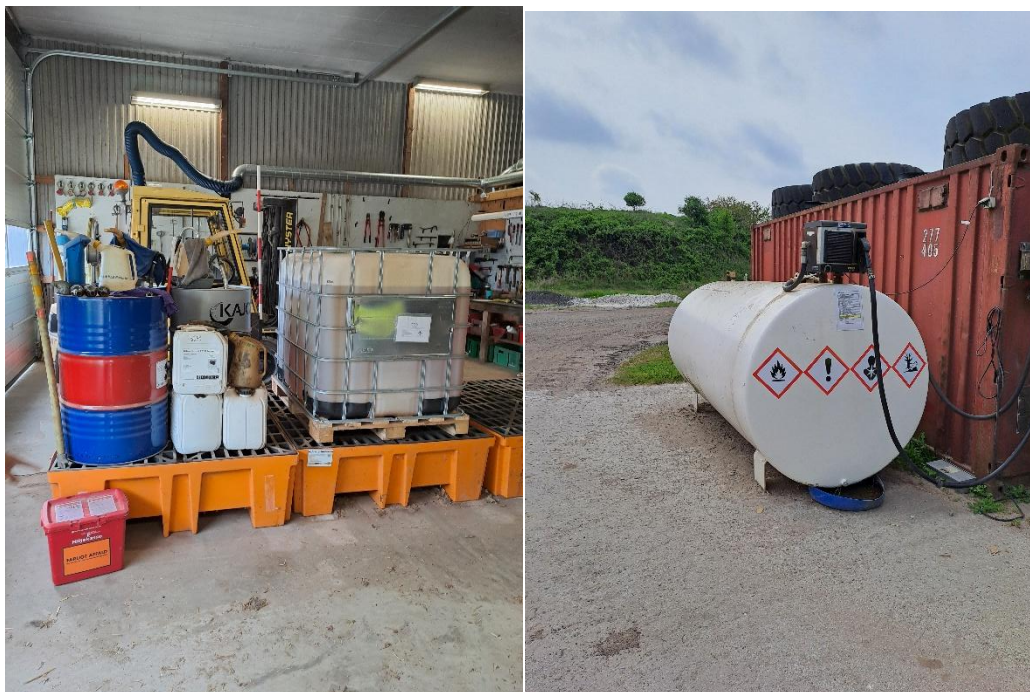
Foto 5 og foto 6 (højre) flydende kemi og olie på spildebakker, højre side, olietank til maskinel.
