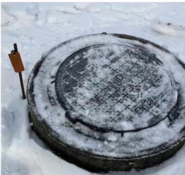
Foto nr. 13a Nyt dæksel til brønd for overfladevand.
