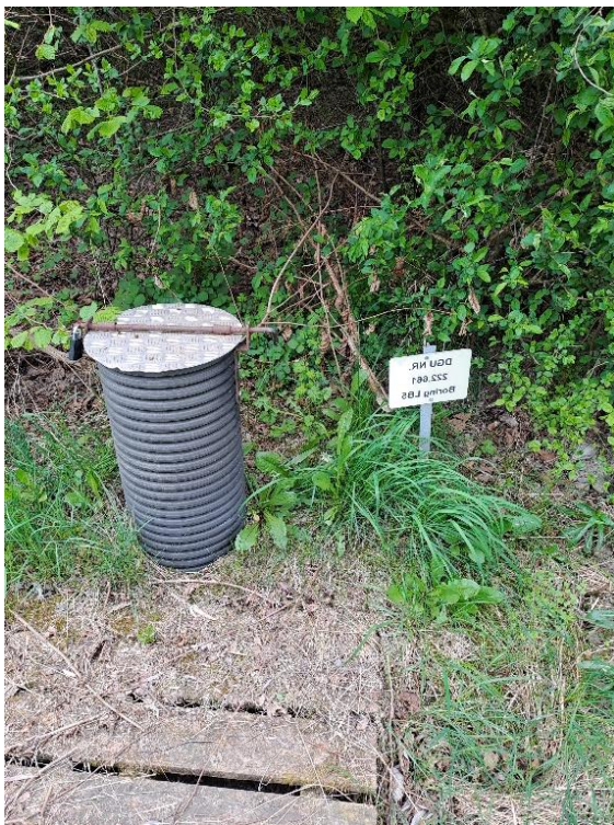
Foto 24. Boring til overvågning af grundvand opstrøms deponiet.
