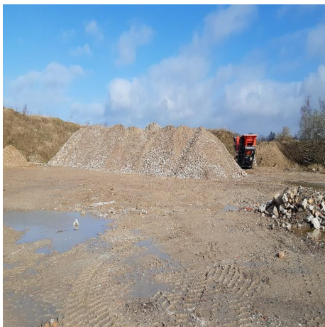
Knust tegl område 1. Til højre udenfor billedet ligger en mindre bunke knust beton
