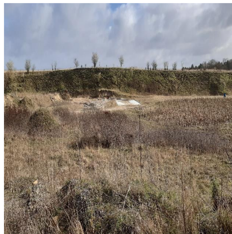
Støbt plads i område 3 til rent træ. Pladsen er tilsluttet tank men ikke tilsluttet en OBU.
