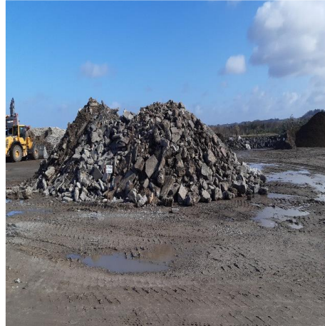
Område 2 bunke med beton til knusning
