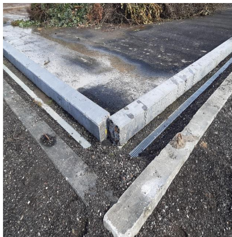
Belægning etableret i område 1 med afløb til tank. Grenplads
